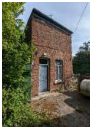
façade de l'existant sur jardin
