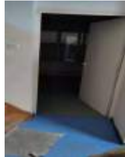
devant l'entrée du logement
