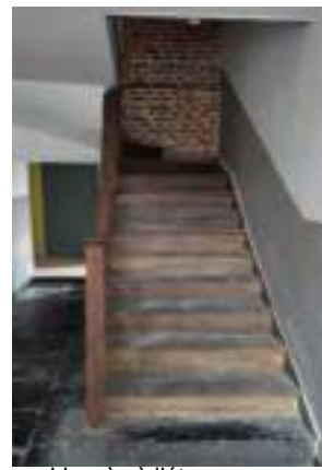
L'accès à l'étage
