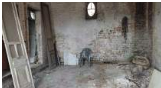
photo de l'existant : RDC partie gauche
