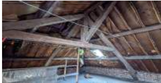
Sous les combles
