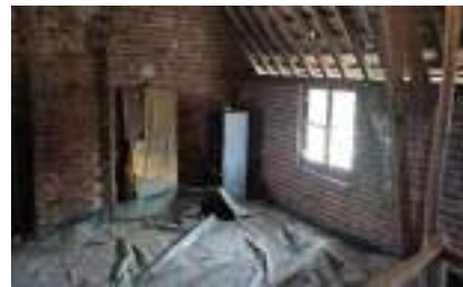
Sous les combles
