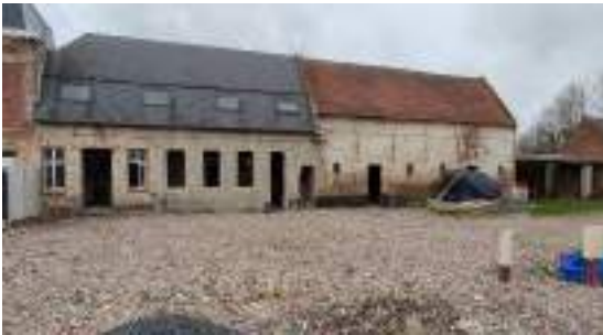
Façade sur cour
